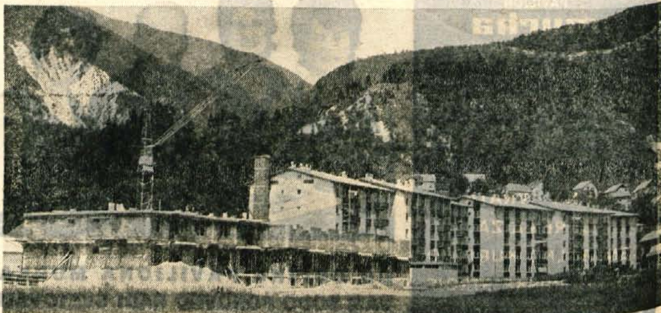
Na Bistrici pri Tržiču raste novo stanovanjsko naselje. Pravkar gradijo dva nova bloka, v katerih bo 120 stanovanj.
