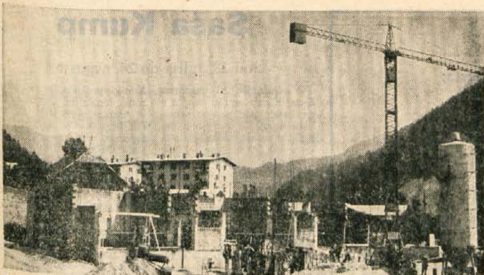
Maja meseca so v Trziču vzdali temeljni kamen za novo osnovno šolo v Bistrici pri Trziču. Gradnja napreduje po načrtu. Šola naj bi bila zgrajena leta 1974.
