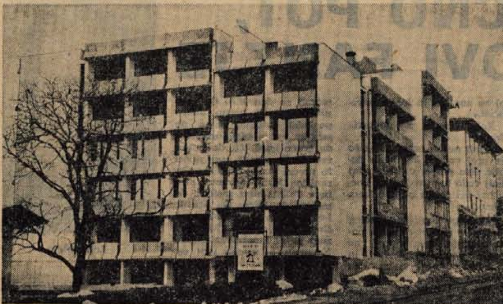
HOTEL KRIM NA BLEDU POVEČUJEJO — Združeno podjetje hoteli Bled se je lani odločilo, da bo povečalo hotel Krim. Dozidali bodo nov del, tako da bo imel hotel skoraj 200 postelj. Gradbena dela opravlja gradbeno podjetje Gorenje iz Radovljice, hotel pa bo odprt ob začetku letošnje turistične sezone. — Foto: F. Perdan
