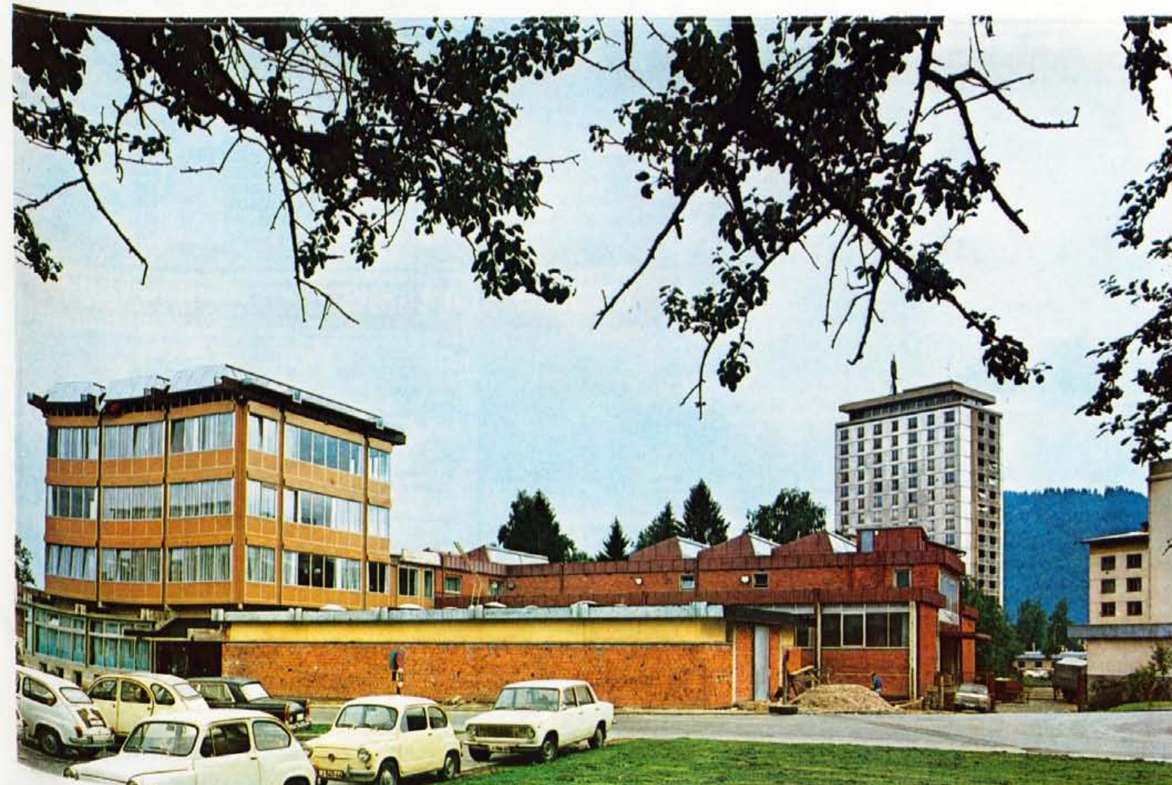
Nova stavba ČP Gorenjski tisk Kranj v ulici Moše Pijadeja
