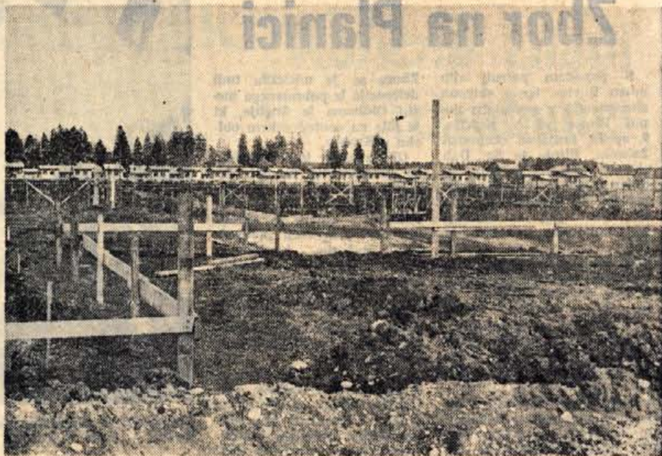
Gradnja nove tovarne Iskre Elektromehanika Kranj na Laborah. — Foto: F. Perdan
