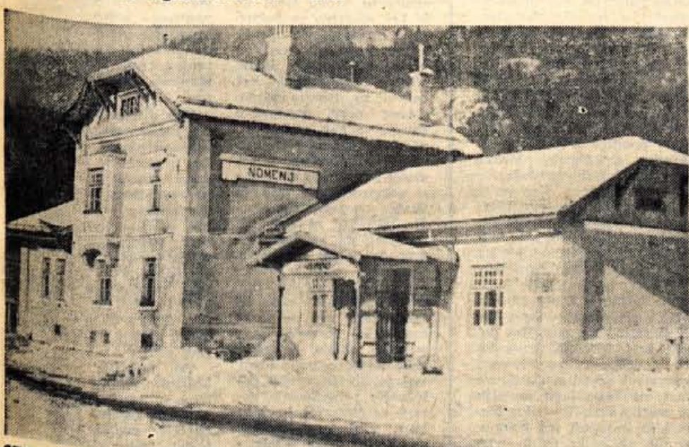
ZTP Postojna je zaradi zmanjšanja železniškega prometa ukinilo več postaj na progi Gorica-Jesenice. Med drugim so ukinili tudi postajo v Nomenju. V zgradbo nekdanje železniške postaje so se zdaj vselili stanovalci, vendar za samo zgradbo zdaj nihče več ne skrbi. Prebivalci Nomenja se hudujejo, kajti zgradba, ki razpada, kraju prav gotovo ni v ponos. — B. B.
