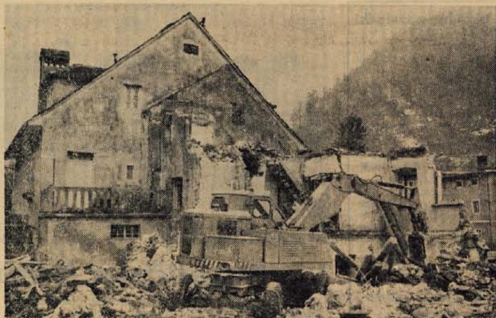
V Trzinu so začeli rušiti hiše, kjer bo stala nova Sapova avtobusna postaja — Foto: F. Perdan
