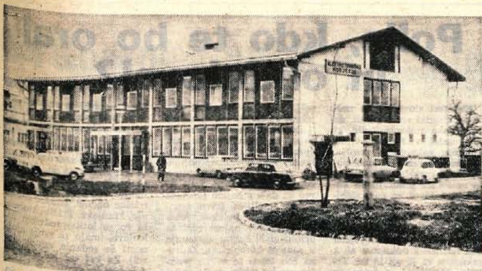
Novi prostori Elektrotehniškega podjetja Kranj. — Foto: F. Perdan
