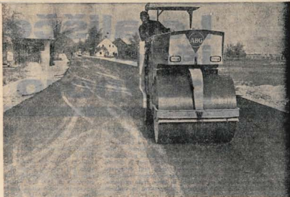
CESTO 2E ASFALTIRAJO — Cestno podjetje Kranj je v sredo že začelo asfaltirati obnovljeni odsek ceste Zabnica—Bitnje. Povedali so tudi, da bodo vsa dela na tem okrog 2 km dolgem odseku končana do 20. novembra. (A. Z.) — Foto: F. Perdan
