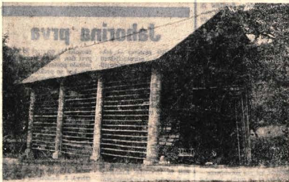
Dvojni kozolec (toplar) na z obio opeko zidanih okroglih stebreh — edinstvena gradbena posebnost stoji ob Jeralovi domačiji v Njivci ob cesti proti Nemiljam.
