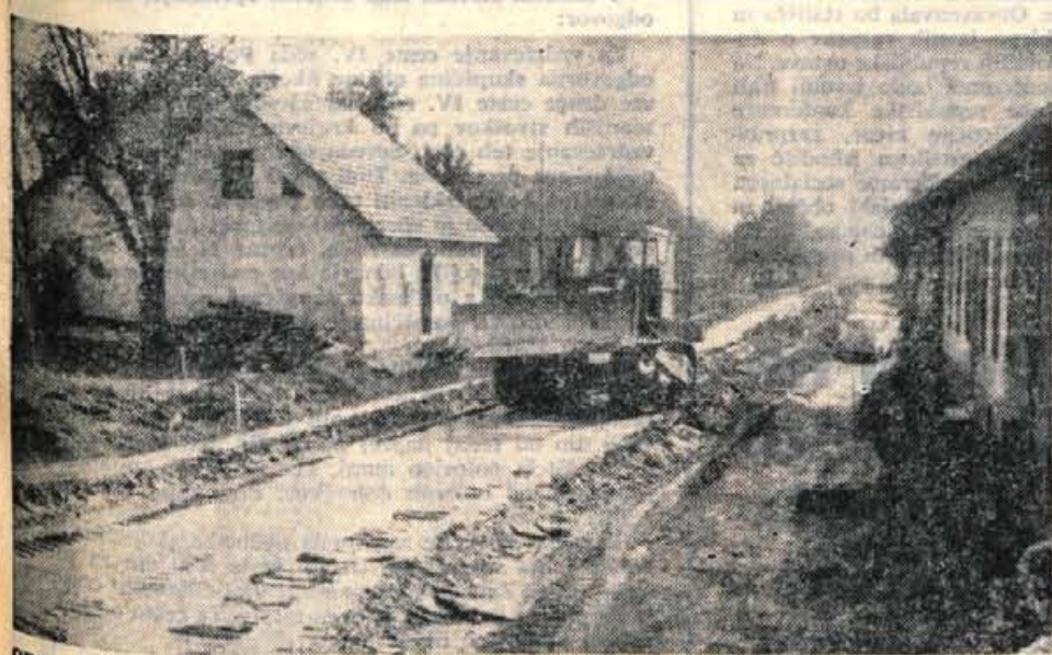
OBNOVA CESTE ZABNICA—ZGORNJE BITNJE — Cestno podjetje Kranj je pred nedavnim začelo obnavljati odsek ceste med Zabnico in Zgornjim Bitnjem. Ta cestni odsek bo približno 1,5 metra širši od lani obnovljenega cestnega odseka Skofja Loka—Zabnica. Letos nameravajo na obnovljeni odsek položiti bitogramoz, spomladi pa še asfaltbeton. Obnovljeni odsek bo dolg okrog dva kilometra. — A. Z. — Foto: F. Perdan
