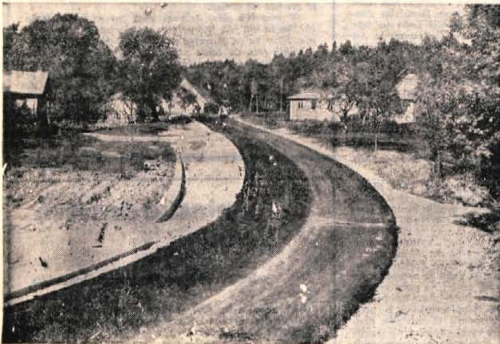
V začetku tega tedna so delavci položili zadnje metre asfalta na razširjeni in preurejeni cesti od Križev do Seničnega. Cesta do Golnika je sedaj dobila svoj asfaltni del, makadamska cesta pa se začne tlačit na občinski mejli. — Foto: F. Perdan
