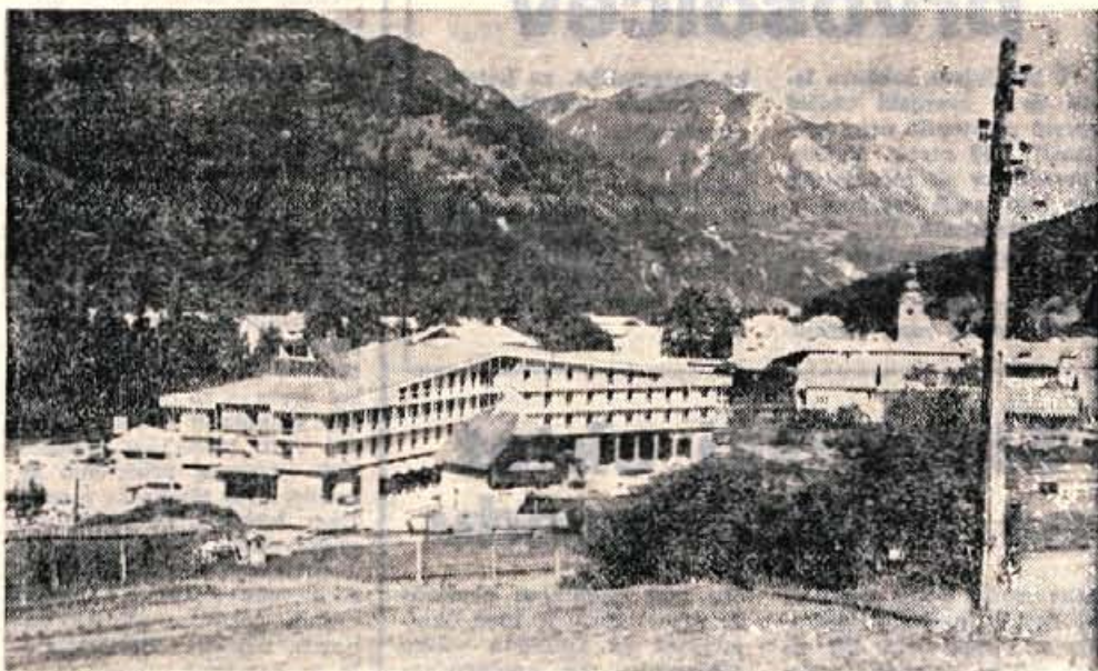
Delavci SGP Sava z Jesenic dokončujejo v Kranjski gori velik hotel, ki bo last gostinskega podjetja Hoteli Gorenjska z Jesenic. V njem bo prostora za 260 gostov. Za razvedrilo gostov bo v zgradbi avtomatsko kegljišče in pokrit bazen. Računajo, da bo hotel opremljen z vsem potrebnim do zime. — Foto: B. Blenkuš
