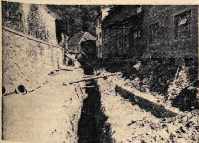
V Parmovi ulici v Kamniku zasipajo strugo Mlinščice in urejajo novo kanalizacijo. — Foto: J. Vidic
