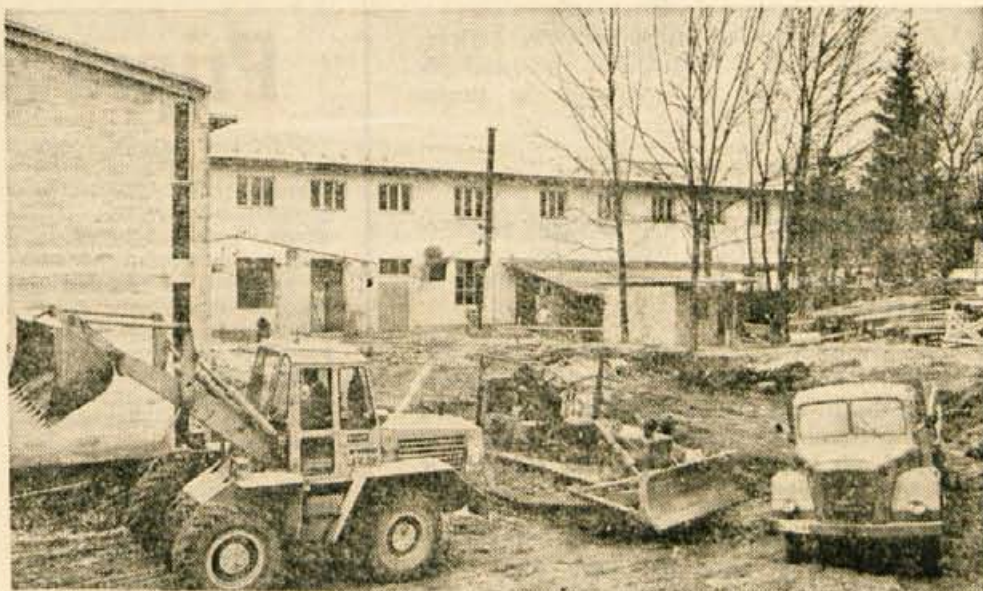
Elra iz Reteč pri Skofji Loki bo letos zgradila novo lakirnico in novo proizvodno halo. V teh dneh so začeli z zemljskimi deli. (Ib) — Foto: F. Perdan
