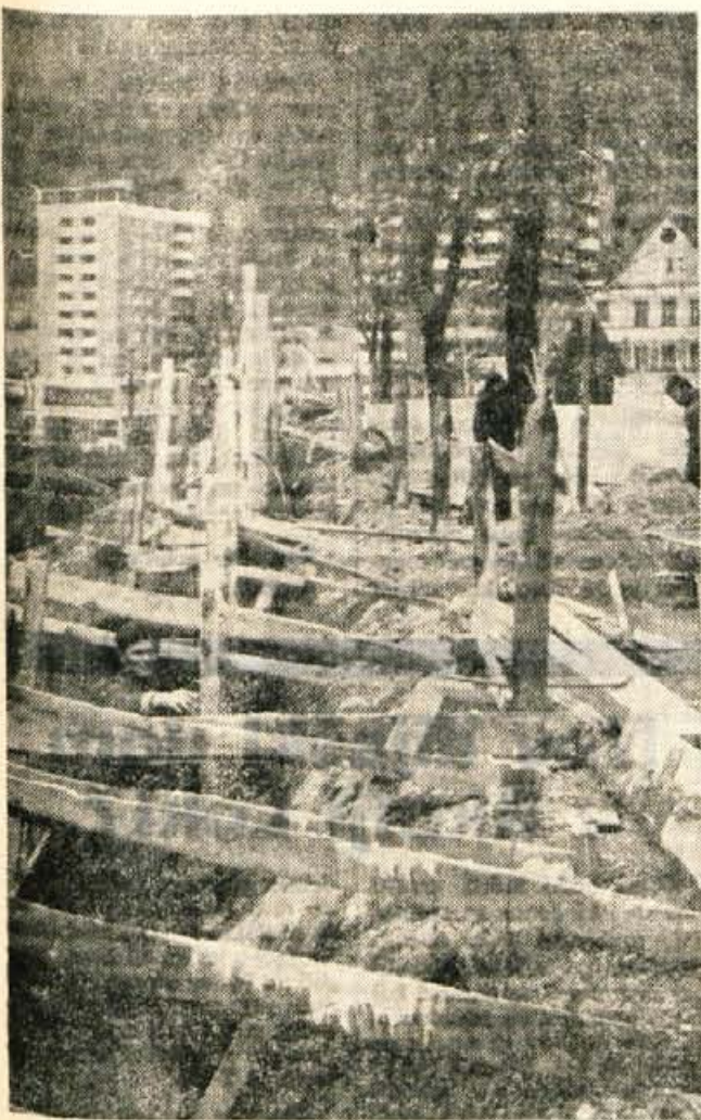
Stanovanjsko podjetje in Železarna Jesenice sta se dogovorila, da bosta za ogrevanje stanovanj od gledališča do železniške postaje na Jesenicah napeljala toplotni vod iz parne centrale v železarni. Začeli so z gradnjo opornega zidu, na katerega bodo vzdali ustrezne nosilce, nanje pa položili cevi za toplo vodo. Na sliki vidimo gradnjo opornega zidu. Delo opravljajo delavci podjetja Kovinar z Jesenic. B. B.
