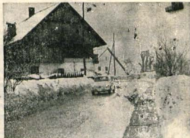
Okoli Cvitarjeve hiše v Logu pri Kranjski gori je cesta speljana v zelo ostrem in nepreglednem ovinku, zato niti ni čudno, da je bilo samo lani to kar pet nesreč. Komlsija za vzgojo in varnost v prometu občine Jesenice je predlagala, da bi hišo odstranili ali pa cesto speljali severneje in se izognili ostremu ovinku. Predvidevajo, da bi za rešitev te prometne težave v zgornjesavski dolini potrebovali 500 do 800 tisoč dinarjev. — B. B.
