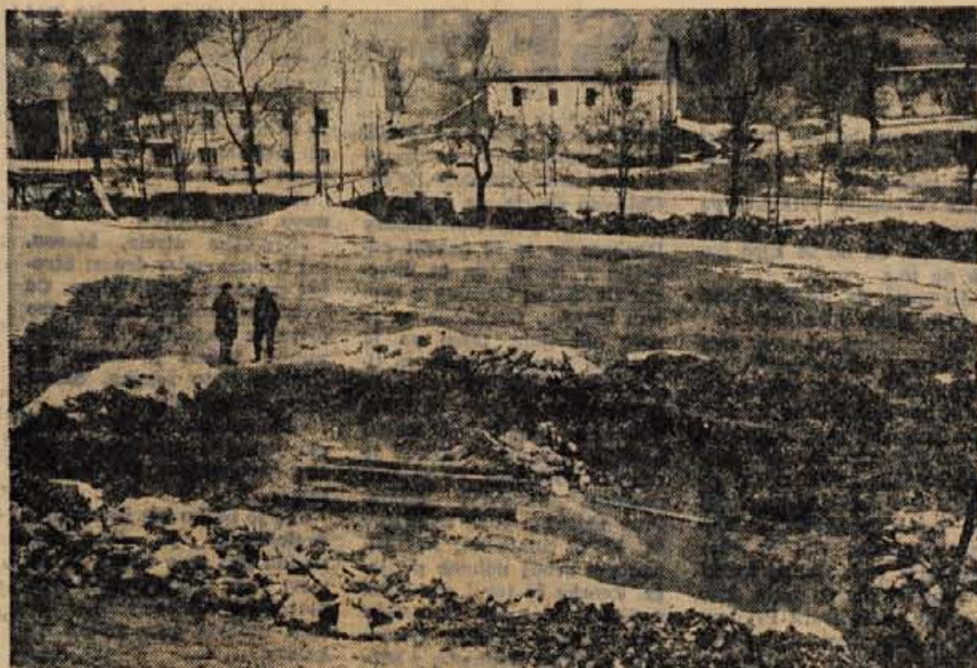
Med kopanjem temeljev za novi bazen, ki pa bržkone še dolgo ne bo zgrajen, so Topličarjevi naleteli na lesene ostanke nekdanjega škofovskega kopališča in na nosilne tramove kabin, postavljenih med »vladavino« dunajske rudniške družbe. — Foto: F. Perdan
