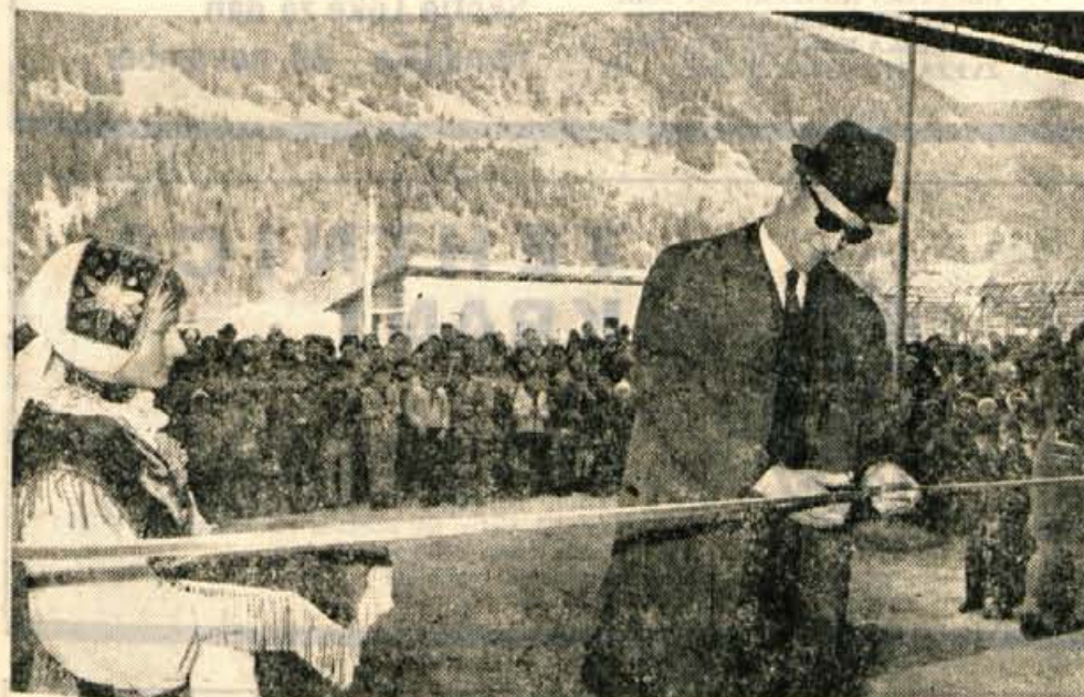
V okviru praznovanja dneva republike v jeseniški občini so včeraj opoldne v Kranjski gori slovesno odprli novo osnovno šolo. S tem se je prebivalec zgornjesavske doline uresničila dolgoletna želja, ki je obenem tudi najlepše darilo za praznik republike. Gradnja šolskega poslopja je veljala 538 milijonov starih dinarjev, ko pa bo dograjena še moderna telovadnica, pa se bo ta številka povzpela na 627 milijonov starih dinarjev. O pomenu nove kranjskogorske šole je govoril predsednik Temeljne izobraževalne skupnosti Jesenice Mihael Cenc, šolo pa je odprl predsednik jeseniške občinske skupščine France Zvan. Učenci kranjskogorske osnovne šole so številnim domačinom in gostom pripravili krajši kulturni program. (Jk) — Foto: F. Perdan
