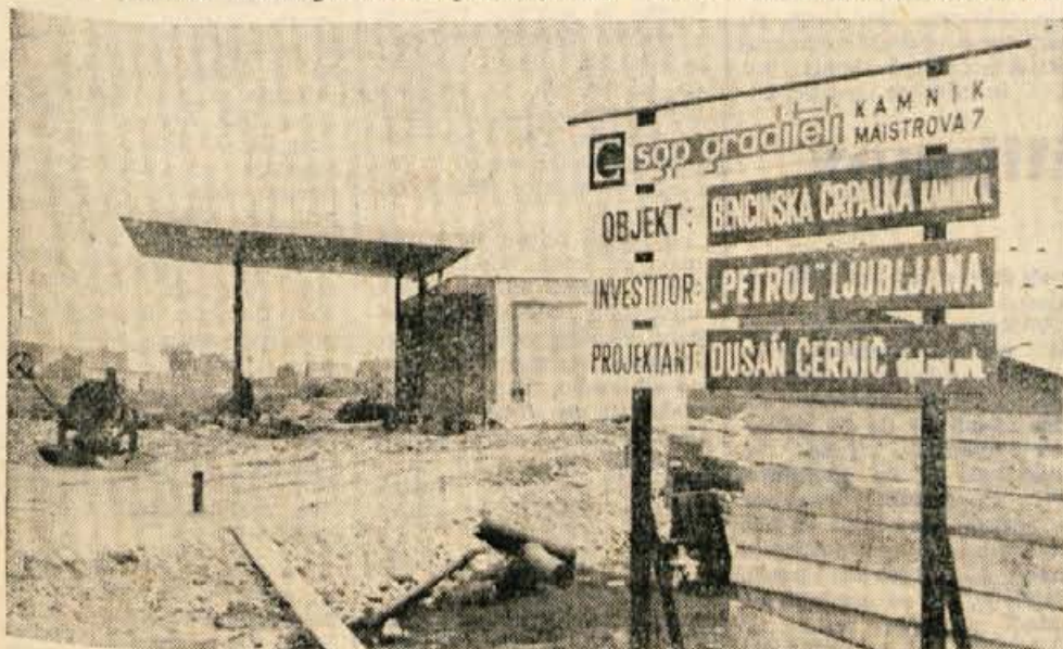
NOVA BENCINSKA CRPALKI — V Kamniku zidajo novo bencinsko črpalko. Gradbena dela izvaja SGP Graditelj iz Kamnika, investitor pa je Petrol Ljubljana. Tako bosta v Kamniku v kratkem dve bencinski črpalke: ena z desne, druga z leve strani ceste. — J. V.
