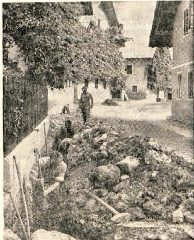
Cestno podjetje Kranj je že asfaltiralo nekatere odseke na cesti Jereka - Stara Fužina. Pred dnevi so prebivalci Srednje vasi urejevali tudi kanalizacijo in vodovodne priključke. Ko bodo ta dela opravljena, bo Cestno podjetje asfaltiralo celotni odsek. — Foto: F. Perdan
