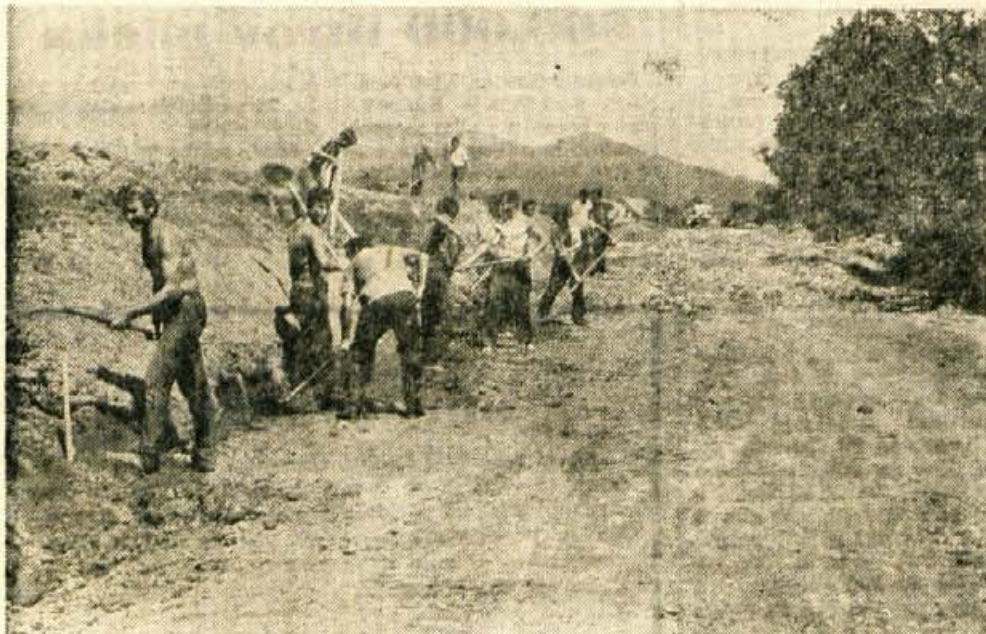
Pred dobrimi štirimi dnevi je Cestno podjetje Kranj začelo z rekonstrukcijo tri in pol kilometra dolgega odseka ceste med Škofjo Loko in Zabnico. Zaplate starega asfalta so že odstranili. Traso sedaj razirjajo in utrjujejo, nato pa jo bodo prekrili z novim asfaltom. (lg) — Foto: F. Perdan
