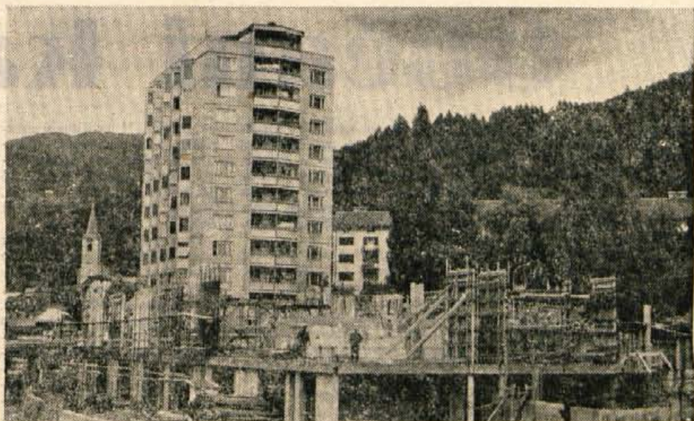
Blagovnica veletrgovine Mercator v izgradnji. Konec letošnjega leta bodo v Tržiču odprili eno najmodernejših trgovskih hiš na Gorenjskem. Njena skupna površina bo znašala 1600 m 2 , od tega bo 1200 m 2 prodajne površine, ostali prostor pa je namenjen za skladišča. Tu bodo: samopostrežna trgovina, mesnica, prodajalna tekstila in čevljev, oddelek za pohištvo in gospodinjstvo opremo (gospodinjstvi stroji, aparati, akustika). Posebnost nove prodajalne bodo premične stopnice in javna telefonska govornica. Predračunska vrednost novega objekta znaša 8 milijonov dinarjev. Izvajalec del je SGP Tržič, načrte je pripravil Arhitekt biro tega gradbenega podjetja, nadzor nad delom pa izvaja Investa Ljubljana, obratna enota Mercatorja. -ok — Foto: F. Perdan
