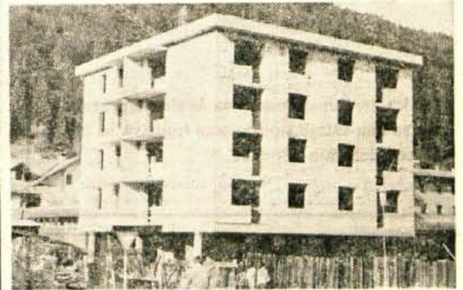
Na Jesenicah za trgovino Rožca SGP Sava z Jesenic gradi štirinadstropni stolpič. V prilicju bodo trgovski prostori in prostori za storitvene dejavnosti, v gornjih nadstropjih pa bodo stanovanja. Računajo, da bo zgradba končana do jeseni.
