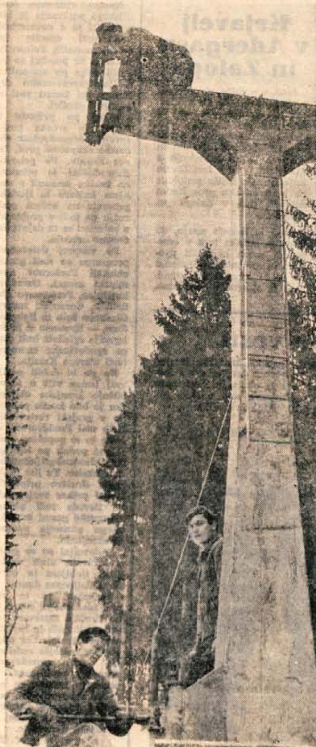
V sredo so postavili zadnji stebler prenovljene žičnice na Stražo — Foto: F. Perdan
