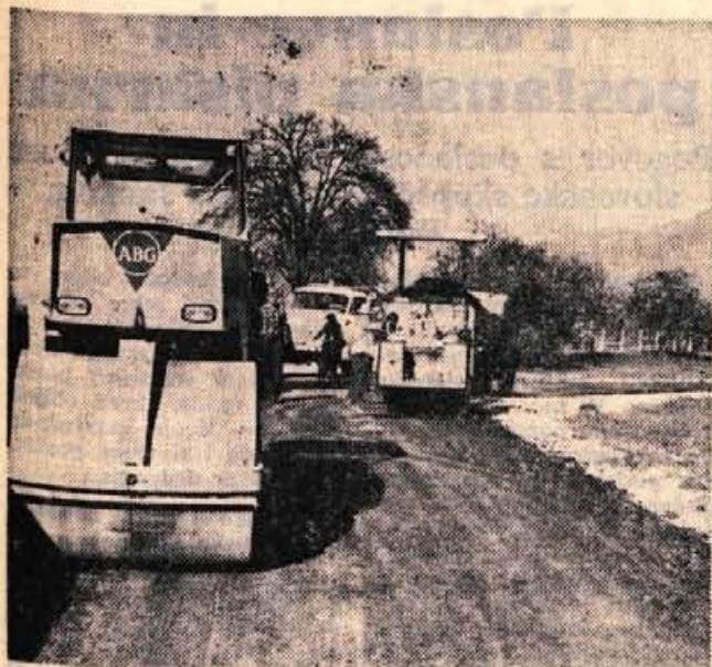
V torek in sredo so pri Radovljici zaprli cesto I. reda. Splošno gradbeno podjetje Gorenje iz Radovljice je izkoristilo lepo vreme in pod cesto blizu podvoza za Begunje pripravilo kanal za bodoči vodovod, ki ga bodo gradili od Ledevnice do Radovljice. Vodni rezervoar v Ledevnici je že zgrajen, začetek gradnje vodovoda pa je predviden za prihodnje leto. (A. Ž.) — Foto: F. Perdan
