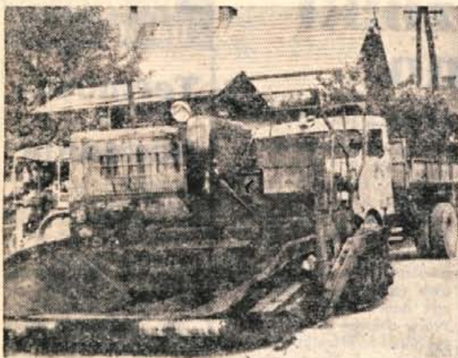
Nova asfaltna prevleka na cesti Naklo — Strahinj.
