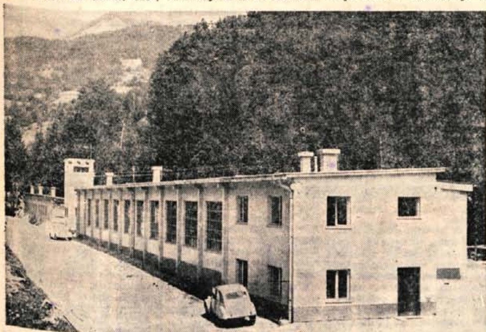
Pogled na novo stavbo hotavelskega podjetja Marmor, v kateri so že začeli izdelovati breton plošče.
