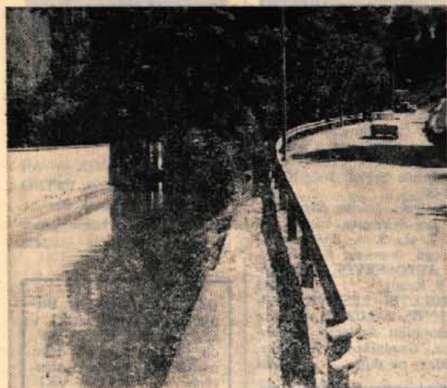
Na cesti Sainte Marie aux Mines v Trziču so pred kratkim zamenjali betonsko ograjo ob Bombažni predilnici in tkalnici s kovinsko. S tem je postala cesta veliko bolj pregledna, povečala pa se je tudi širina ceste — Foto: F. Perdan
