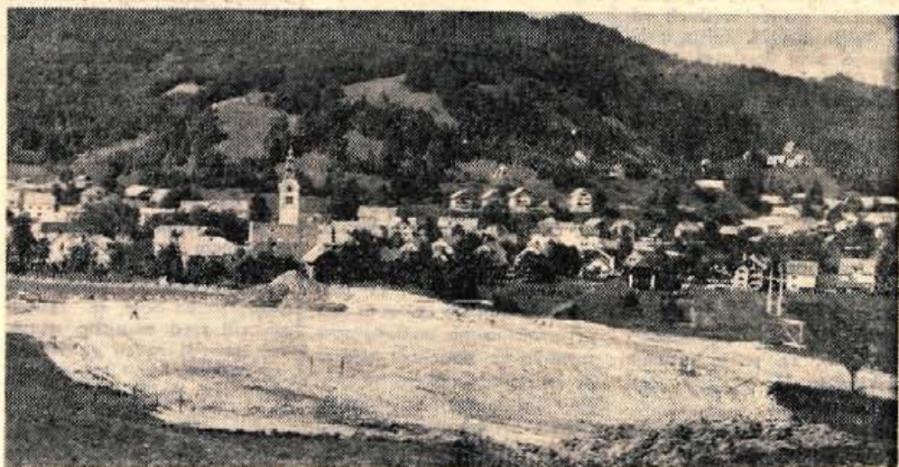
V Gorenji vasi so nedavno tega začeli z zemeljskimi deli, s planiranjem terena, kjer bo stala nova šola. Postavilo jo bo splošno gradbeno podjetje Tehnik iz Škofje Loke. Sredstva zanjo je deloma prispevala skupščina, deloma pa občani sami, ki so se lani na referendumu izrekli za samoprispevek za gradnjo šol. — Foto: F. Perdan
