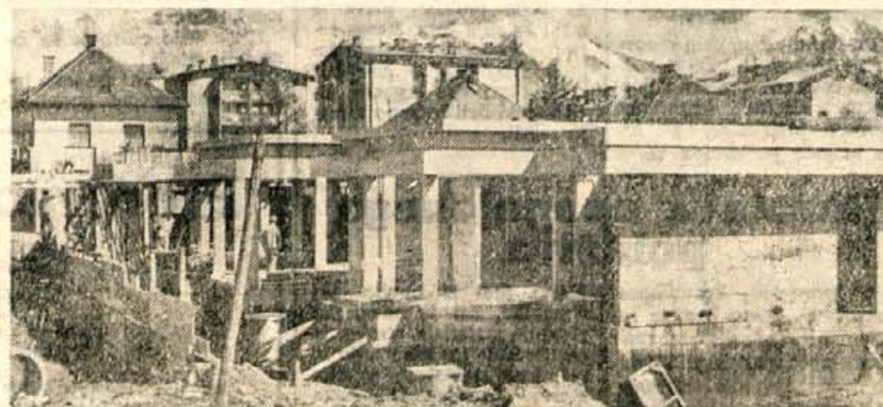
Še letos bo v naselju Vodovodni stolp v Kranju zgrajena nova vzgojno-varstvena ustanova. Investitor je kranjska občinska skupščina, dela pa izvaja Splošno gradbeno podjetje Projekt Kranj. — Foto: F. Perdan
