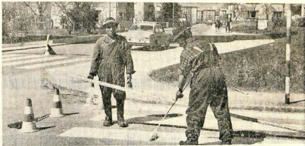
Pred kratkim so na kranjskih ulicah začeli pleskati prehode za pešce. Zal pa dela kljub večjemu prometu počasi napredujejo, saj delo opravljata le dva delavca...?! — Foto: Franc Perdan
