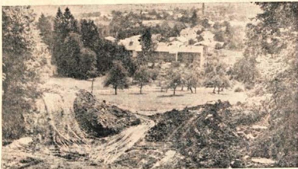
Podjetje Megrad iz Ljubljane gradi v Stražišču pri Kranju akumulacijski vodovodni rezervoar, ki naj bi v poletnih konicah preprečil pomanjkanje pitne vode v Kranju in Stražišču. Prostornina rezervoarja bo znašala 1050 kubičnih metrov, dograjen pa bo maja prihodnjega leta. Investitor za izgradnjo tega rezervoarja je komunalno podjetje Vodovod Kranj in bo po predračunih veljal okrog 45 milijonov starih dinarjev. Novi rezervoar bo hkrati pomenil tudi osnovo za začetek gradnje vodovoda Stražišče—Zabnica. (A. Z.) — Foto: F. Perdan
