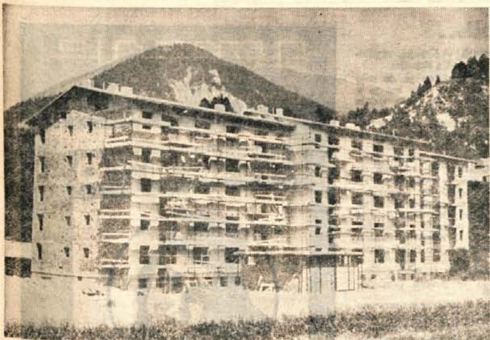
V Bistrici pri Trziču gradi kranjski Projekt 60 stanovanj za trg. Po načrtih bodo stanovanja vseljiva že letos septembra. V kratkem pa bo omenjeno gradbeno podjetje začelo graditi v soseski B-4 v Bistrici še drug stanovanjski blok s 60 stanovanji, ki bodo vseljiva prihodnjo jesen. (vig) Foto: F. Perdan
