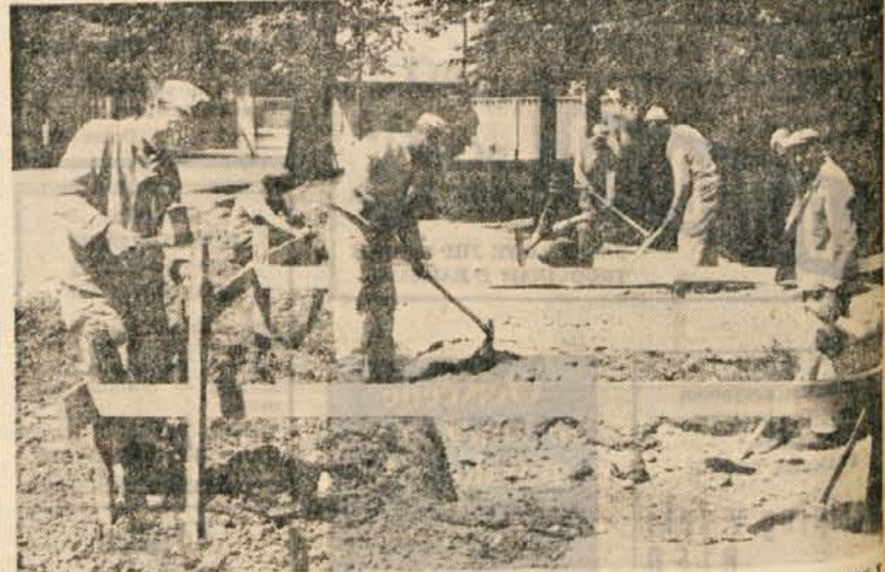
Nekaj dni pred prvomajskimi prazniki so začeli graditi tudi v Kranju mali golf, in sicer v gozdčiku pri stadionu oz. kopaljšču. Delo opravlja kranjsko gradbeno podjetje Projekt, mali golf pa financira podjetje Central. Predvidevajo, da bo mali golf — prvi v Kranju — do polne turistične sezone narejen — Foto F. Perdan
