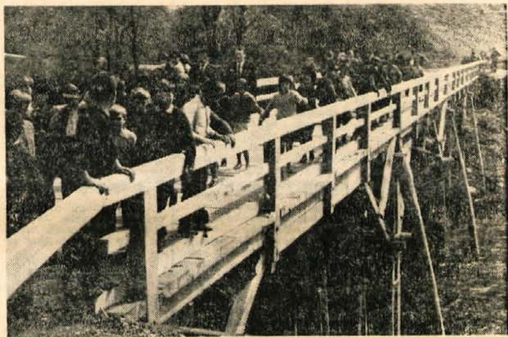
Prejšnji torek nekaj pred drugo uro je predsednik občinske skupščine Škofja Loka Zdravko Krvina odprl nov most čez Savo, ki povezuje Suho z vasjo Hosta. Most je lesene konstrukcije, dolg 52 metrov. Zgradilo ga je splošno gradbeno podjetje Tehnik iz Škofje Loke v zelo kratkem času — v dveh mesecih. Od tega dne dalje pa je zaprt most v Puštalu. Delo pri gradnji tega mostu bo odslej lahko potekalo nemoteno in hitreje. — Foto: F. Perdan
