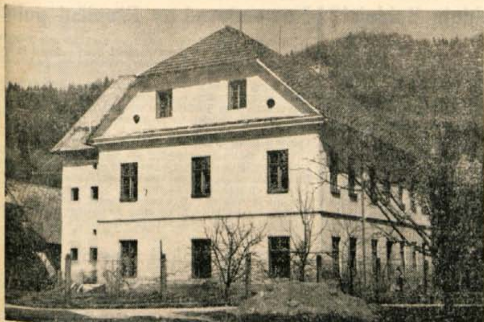
Solsko poslopje v Gorenji vasi je bilo zgrajeno leta 1880 in je že zdavnaj premajhno za današnje potrebe. — Foto: F. Perdan
