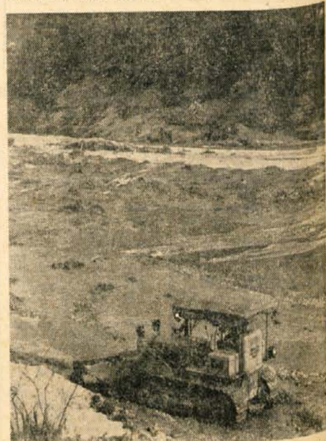
Vodna skupnost Gorenjske je te dni začela z regulacijo desnega obrežja Bistrice zaradi zavarovanja mostu in naselja Zeje. Dela pri urejanju struge v dolžini 500 m bodo trajala približno tri mesece — Foto: F. Perdan
