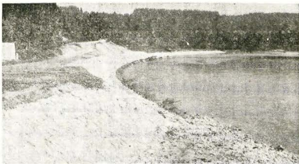
Med Posavcem in Podnartom je Vodna skupnost Gorenjske pred kratkim končala z letošnjim urejevanjem levega obrežja Save. Na tem mestu je Sava pri vsakih poplavih odnašala zemljo in grozila, da bo prišla do ceste. Z deli bodo nadaljevali prihodnje leto. — Foto Franc Perdan
