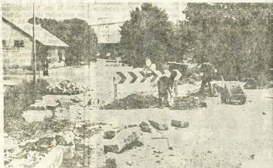
V Kranju delavci Komunalnega podjetja pravkar urejajo obvoz pri železniški postaji. Zaradi vse večjega prometa je tu posebno ob konicah prišlo do zastojev v prometu. Zato bodo sedaj uredili avtobusno postajališče za odhode proti Ljubljani pri sedanjem odcepu na železniško postajo (stari del ceste pa bodo za motorna vozila zaprli). Postajališče za odhode proti Kranju oziroma na Gorenjsko pa bodo uredili pred restavracijjo tovarne Iekra Foto Franc Perdan
