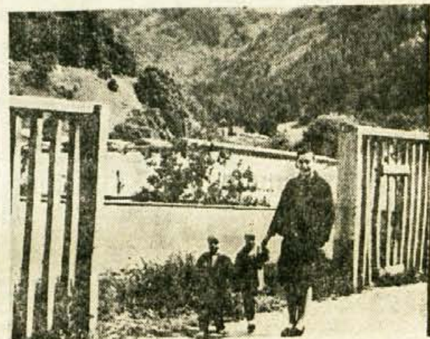
NEVARNO, KER NI OGRAJE — Ob Cesti Ste Marie aux Mines v Tržiču, ki vodi od vhoda v BPT proti mostu ob nekdanji železniški postaji, je betonska ograja, ki pa je na nekaterih mestih podrtja. Najnevarnejši je podrti del na sliki, saj komaj pol metra zadaj teče po umetni strugi del Tržiške Bistrice, voda pa je globoka približno 1,5 m. Kaj bi bilo, če bi se kdo zvrnil v strugo? — Foto Perdan
