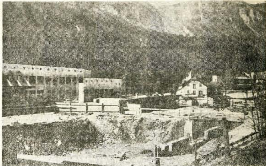
Na Jesenicah so nasproti železniške postaje začeli graditi trgovsko stanovanjsko stavbo; že so izkopal jama in začeli betonirati temelje. Investitor stanovanjskega dela stavbe je splošno gradbeno podjetje Sava Jesenice, investitor trgovskega dela pa Turist-progres Radovljica z jamstvom podjetij Murka Lesce, Špecerija Bled, Železnina Radovljica in Kmetijsko gospodarstvo Škofja Loka. Vsa dela izvaja gradbeno podjetje Sava — Foto F. Perdan
