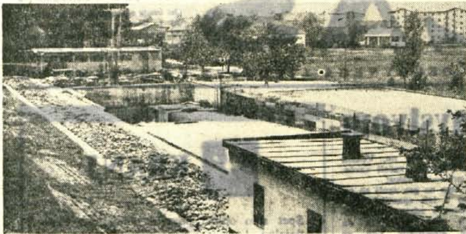
Rekonstrukcija radovljanskega kopališča počasi a vztrajno napreduje. Za sedaj je »novi« bazen dobil že svoje prve grobe oblike. Pri rekonstrukciji je pokazalo SGP »Gorenje« iz Radovljice veliko razumevanja za vse težave, ki nastajajo Foto F. Perdan
