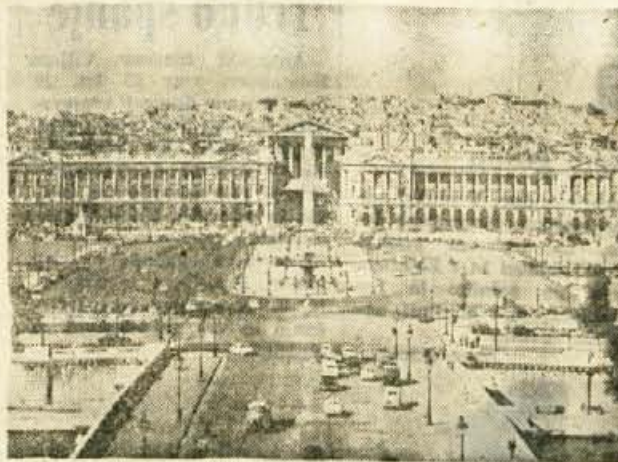
Pariz — Splošen pogled na Place de la Concorde
