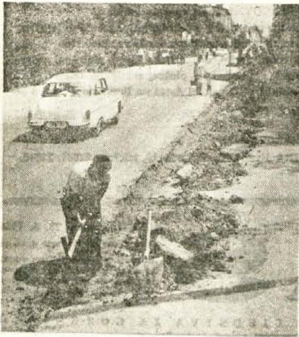
Na Bledu prekopavajo Ljubljansko cesto; med pločnikom in cestiščem vstavljajo robnike, pločnike pa bodo potem asfaltirali — Foto Perdan
