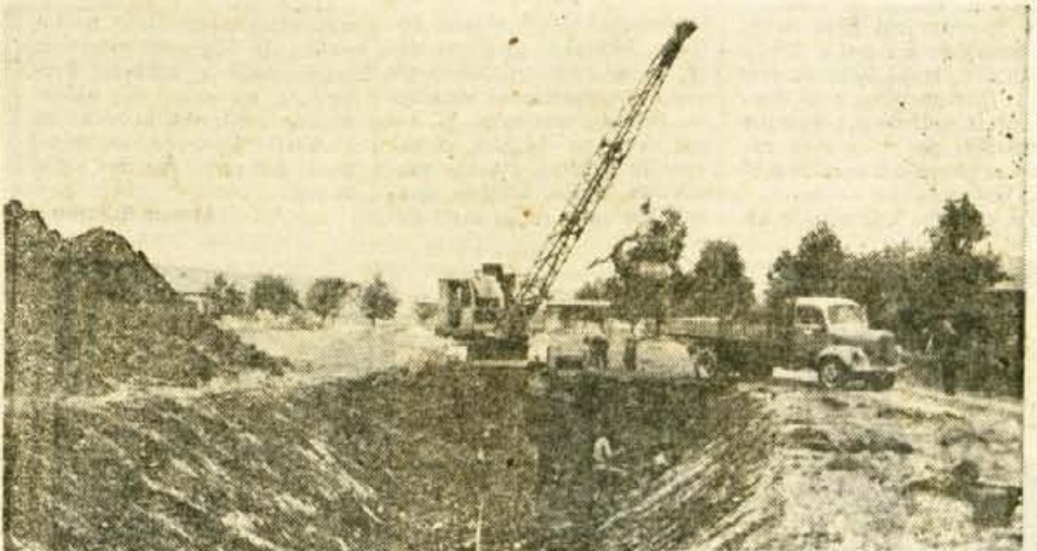
V zadnjih letih so kmetje in sploh vsi prebivalci med Komendo in Mostami doživljali mnoge nevedčnosti zaradi poplav potoka Pšata. To je posebno zato, ker je preurejena, dvignjena cesta preprečila hitrejši odtok vode. Zato Vodna skupnost Ljubljana tu koplje globok odtočni jarek, ki bo preprečil nadaljne poplave
