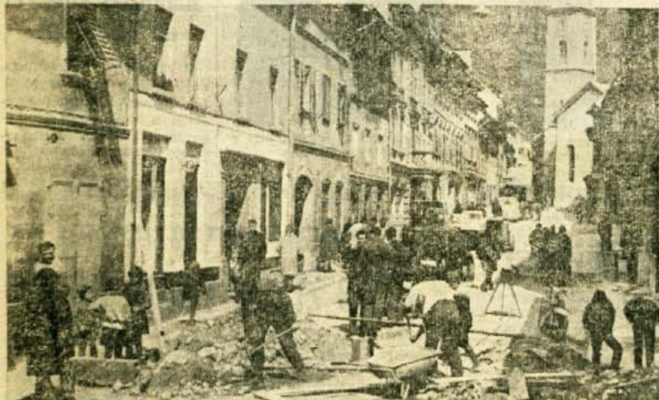
Središče Trzica — Trg svobode je te dni v »remontu«. Da bi uredili cesto in pločnike za pešce, bodo najprej uredili rove in jaskice za poznejšo instalacijo električnega, telefonskega in drugega omrežja. Bil je res že skrajni čas, da to uredijo.
