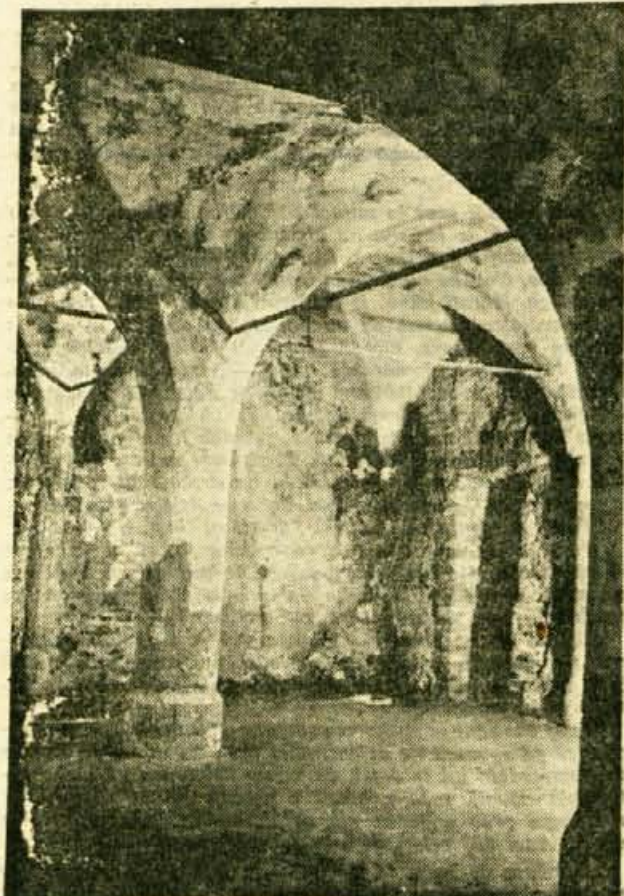
Mestna hiša v Kranju. Novo odkrita stenslična dvorana iz prve pol. 16. stoletja med restavriranjem
