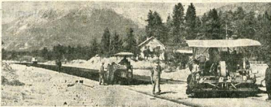
Dela na novi gorenjski cesti gredo končno le h kraju; te dni namreč asfaltirajo več kilometrov dolg odsek te ceste med Brezjami in Crnlivcem. Gorenjska magistrala od Podtabra do Podvina bi do pomladi morala biti gotova, čeprav je bilo pri gradnji doslej precej zastoj in težav. Upajmo, da se bomo spomlad po novi cesti že lahko vozili — Foto Perdan
