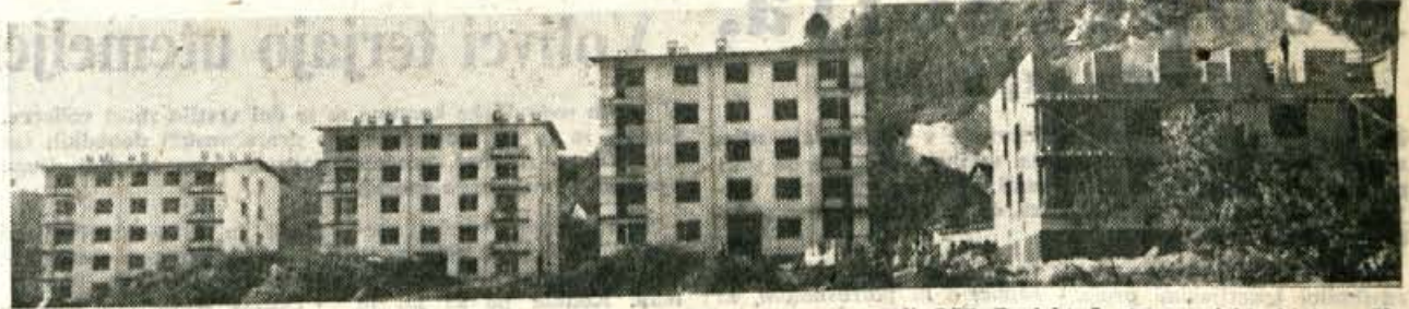
V Bistrici pri Trzinu v bližini nove bencinske črpalke ob Ljubeljski cesti, gradi SGP Projekt 5 stanovanjskih blokov. V enega (na sliki skrajni levi), ki je last tovarne Peko Trzin, so se prejšnji teden že vselili — Foto Perdan
