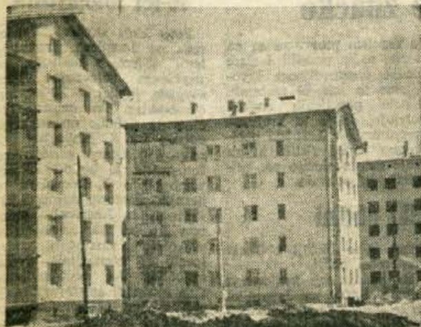
Novi stanovanjski bloki ob Kamniški cesti v Domžalah, ki so povzročili mnogo težav občinskemu organom in graditeljem ter veliko hude krvi med bodočimi stanovalci
