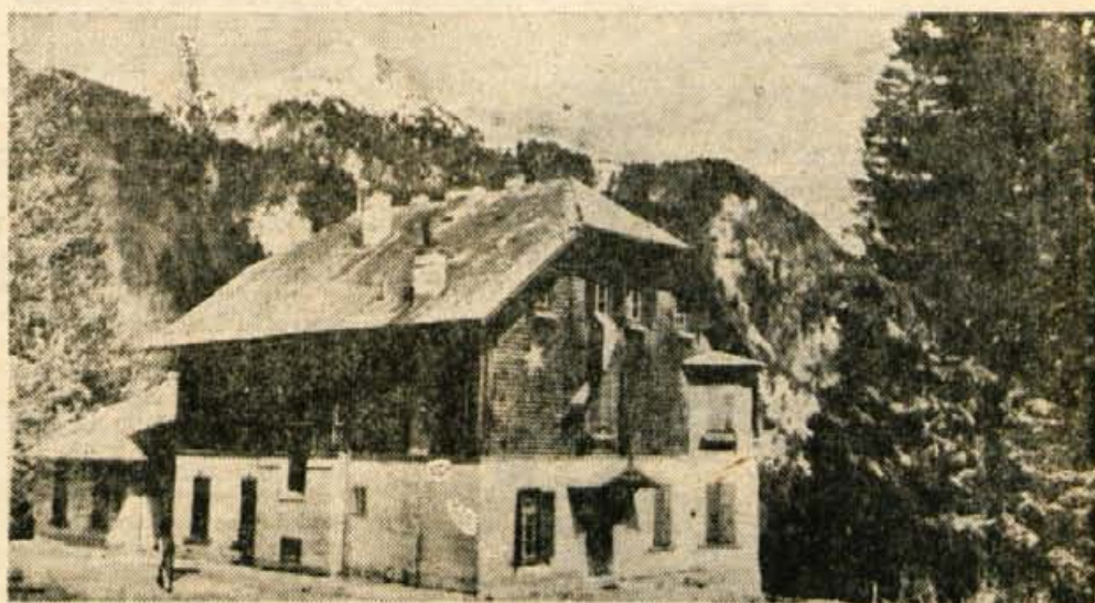
Neizkoriščen dom »Staneta Zagarja« na Ljubelju
