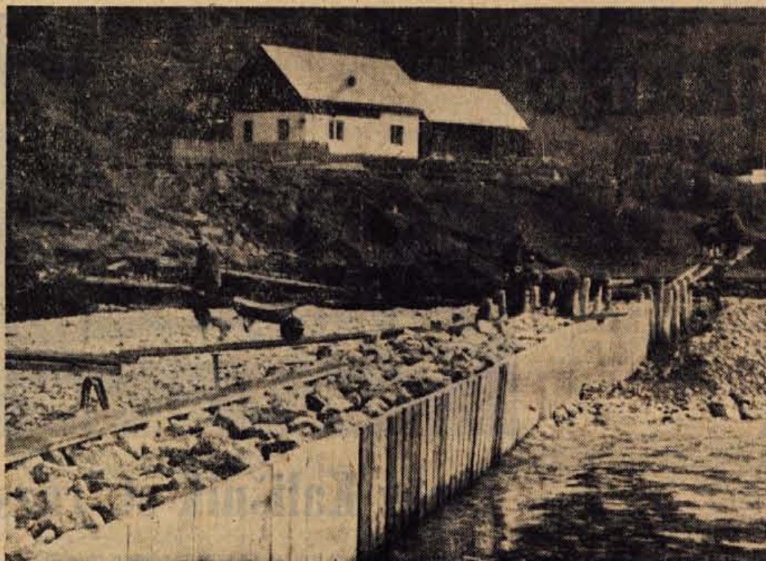
Slika prikazuje porušeno cesto med Podnartom in Krovo. Na njej se vidi obrambni zid, ki ga dela Vodna skupnost Gorenjske
