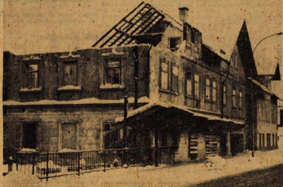
Pred kratkim so na Jesenicah začeli podirati »Mesarjevo« hišo. Umakniti se mora delu novega podvoza pri jeseniški železniški postaji, ki bo eden izmed najvažnejših objektov v tem kraju
